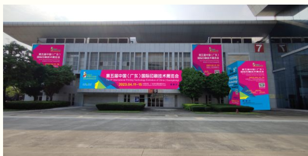
7号馆外墙广告
