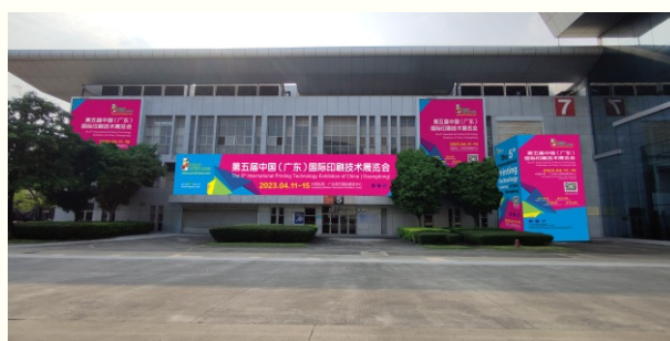
7号馆外墙广告
